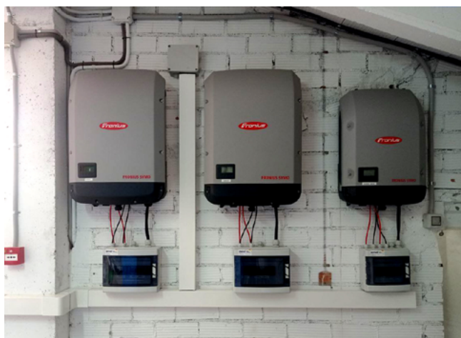
/ Inversores Fronius con tres rangos de potencia
